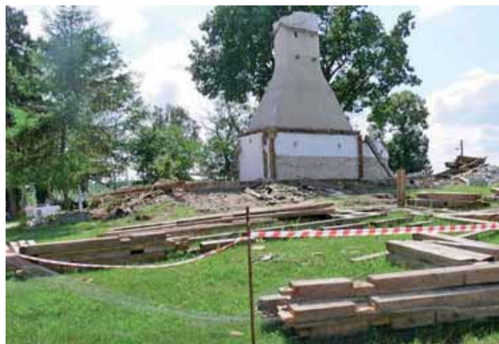
Specjaliści w dwa tygodnie rozłożyli dwór na części pierwsze, pozostawiając po zabytku murowany piec z wysokim na kilka metrów szybem i ledwie widocznym kominem
