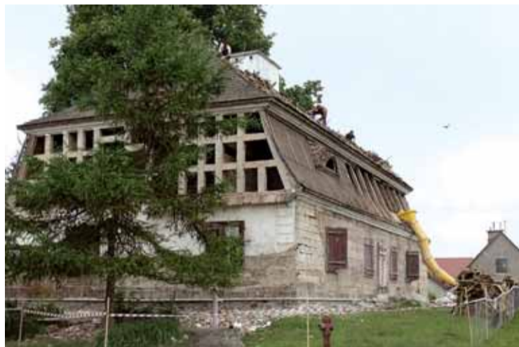
Dwór w czasie rozbiórki
